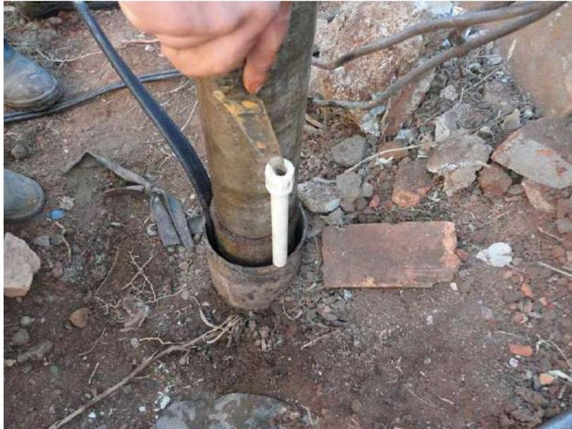
**Foto 4.9** Espaço insuficiente entre tubulação e revestimento do poço.
