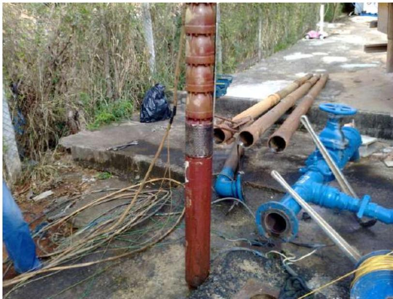
**Foto 4.2** Retirada do equipamento de bombeamento do PT-72.
