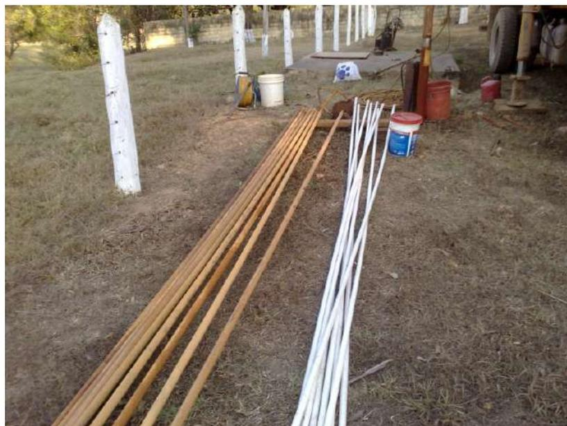
**Foto 4.4** Tubulação do PT-78 e tubos para a medição de nível.
